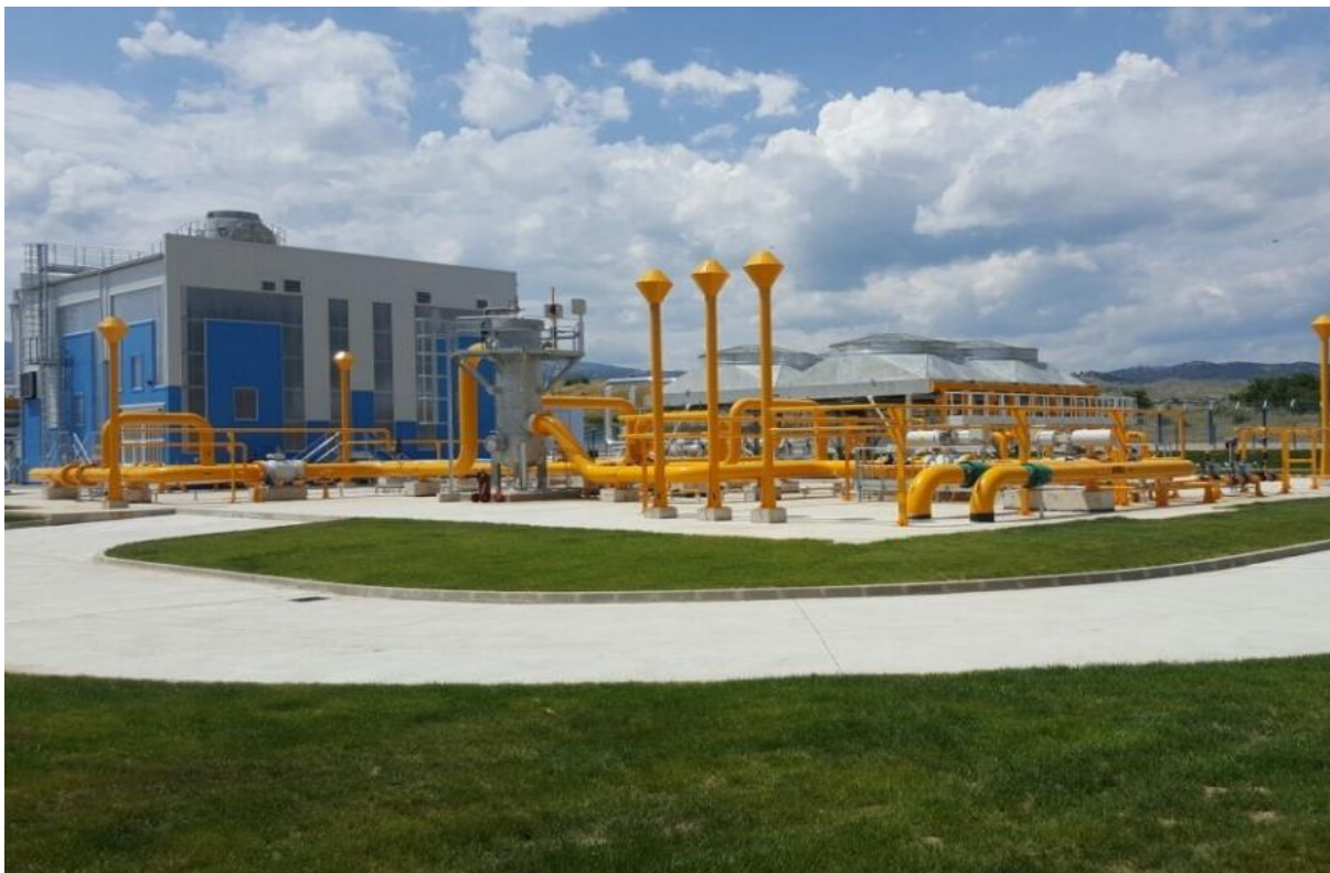
Компресорна станция „Ихтиман“
