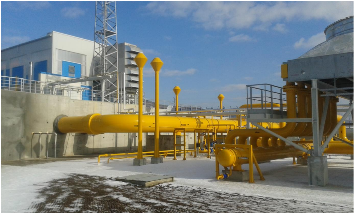
Компресорна станция „Лозенец“
