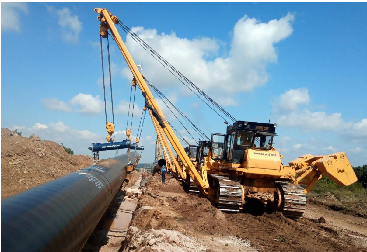
Строителство на линейна част на газопровод високо налягане
