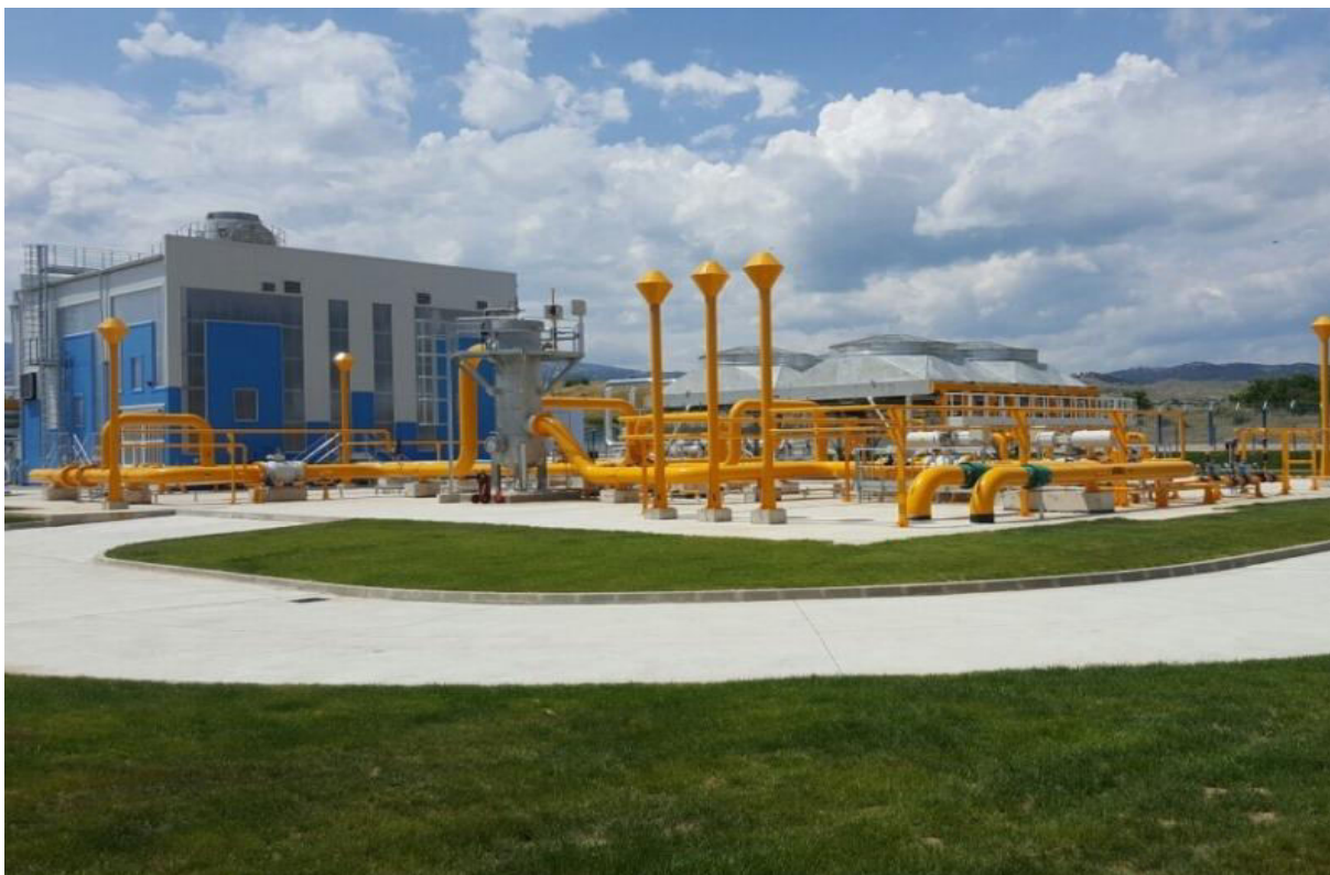
Компресорна станция „Ихтиман“
