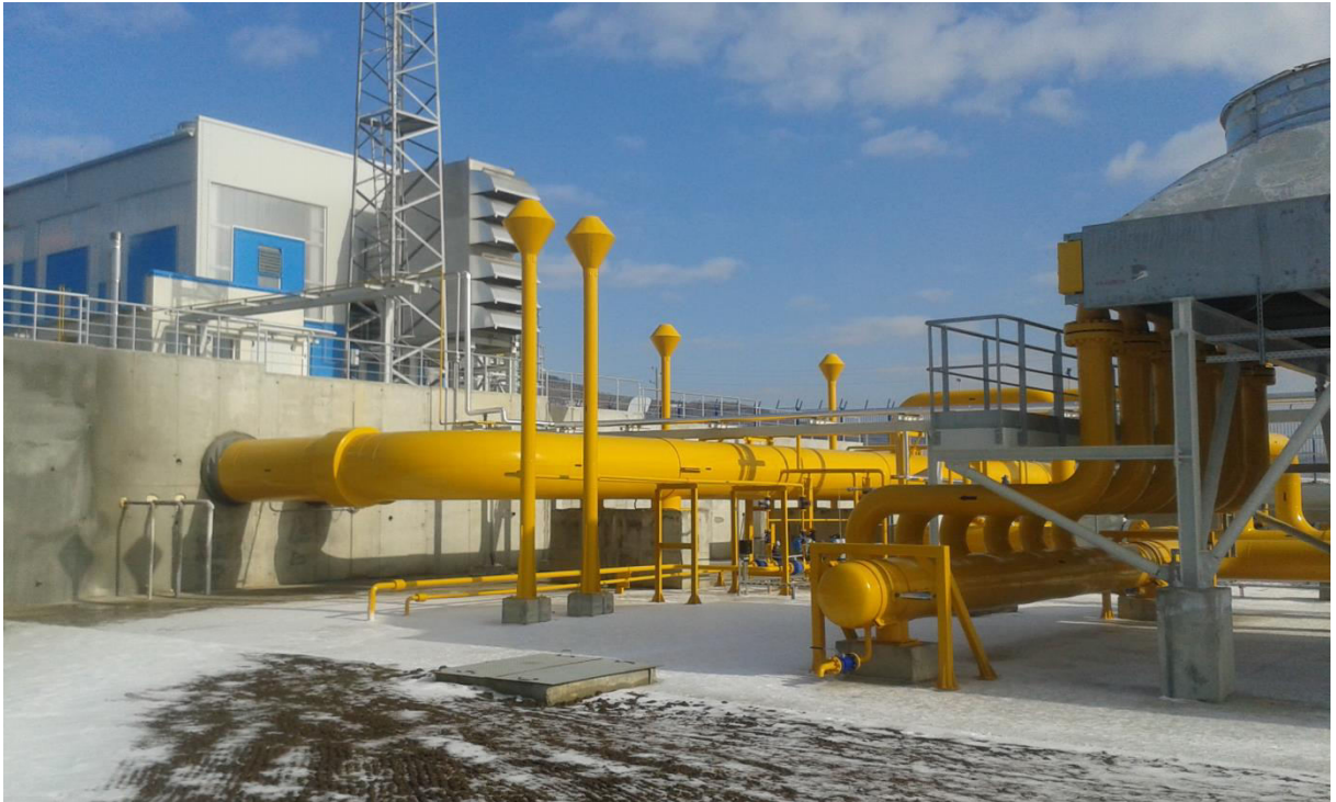
Компресорна станция „Лозенец“
