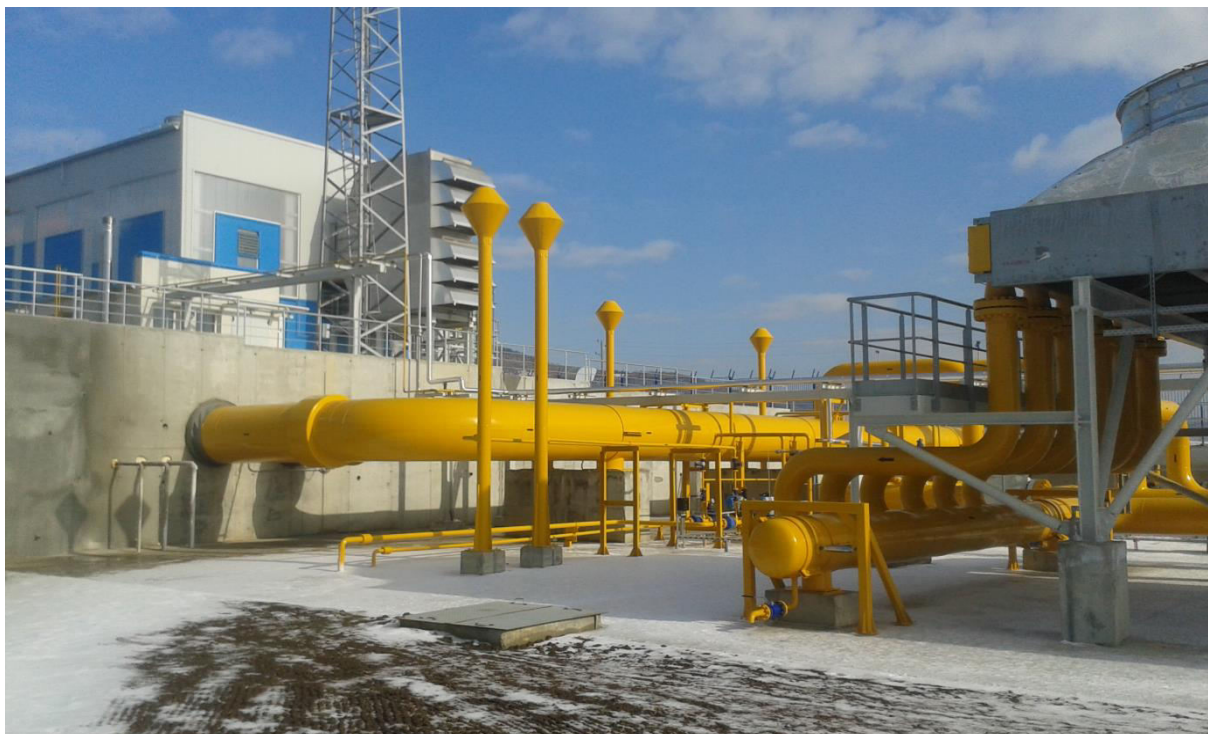
Компресорна станция „Лозенец“
