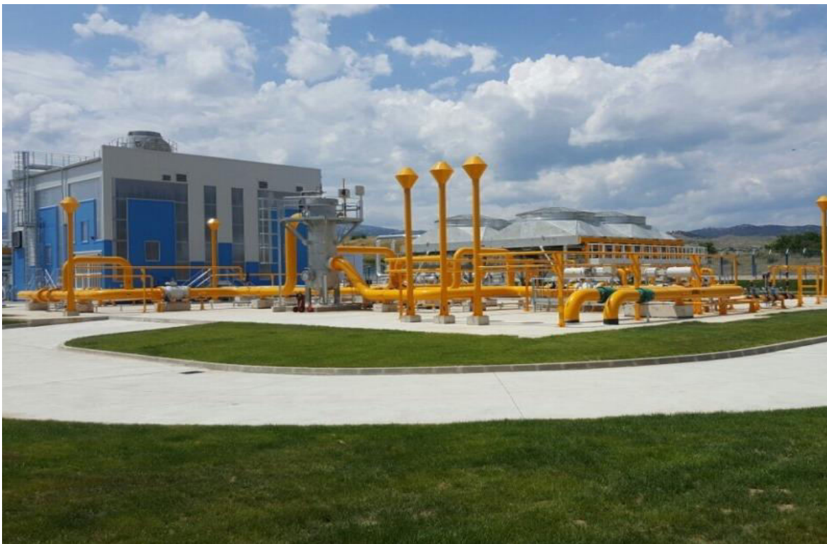
Компресорна станция „Ихтиман“
