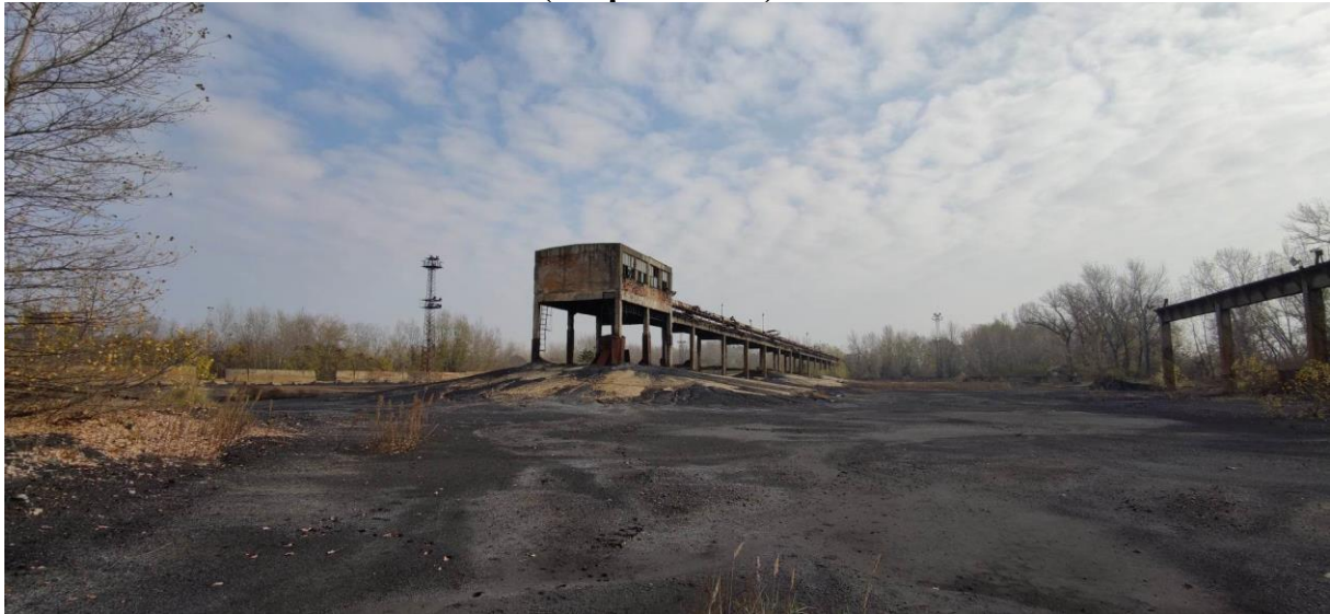
Снимка 9: Въглищно стопанство (открит склад)
